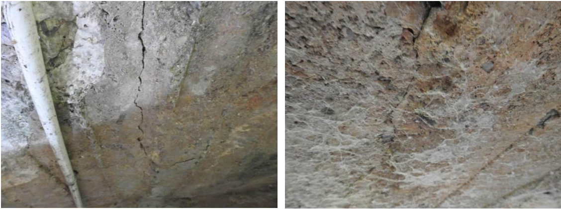
图 3 主拱圈 U 形裂缝
